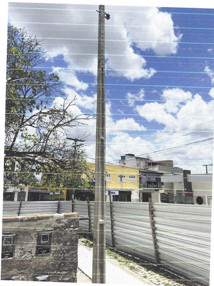
Foto 19 - Poste de concreto duplo t, resistência nominal 200kg, h=8,00m, peso aproximado 400kg
