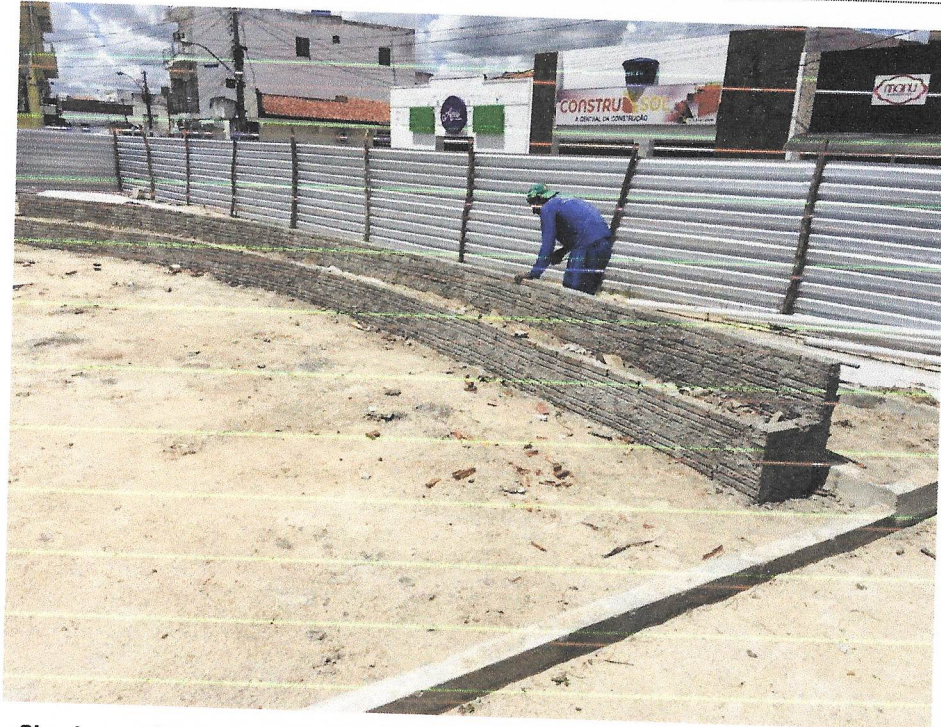
Foto 13 - Chapisco aplicado em alvenarias e estruturas de concreto internas, com colher de pedreiro, argamassa traço 1:3 com preparo em betoneira 400l. af_06/2014
