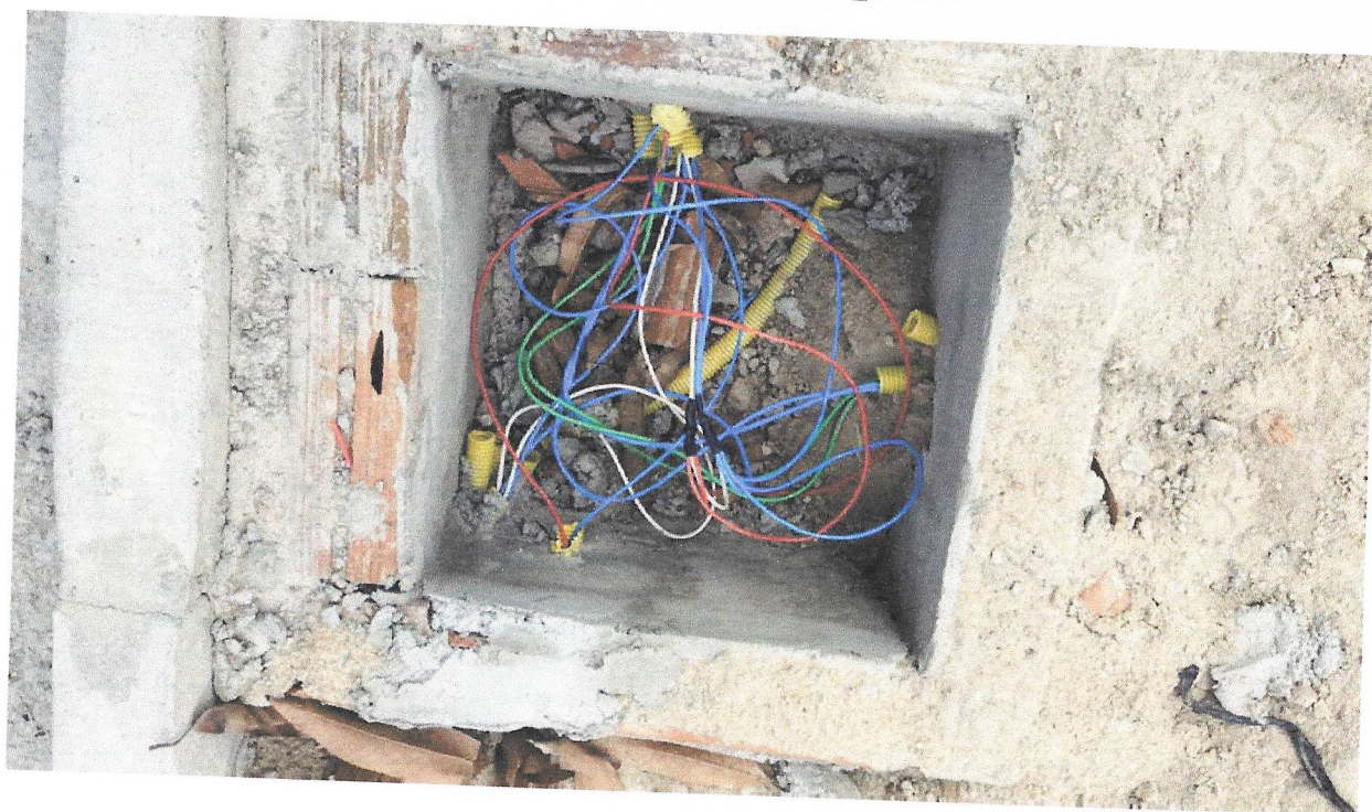
Foto 17 - Cabo de cobre flexível isolado, 6 mm 2 , anti-chama 450/750 v, para circuitos terminais - fornecimento e instalação. af_12/2015
