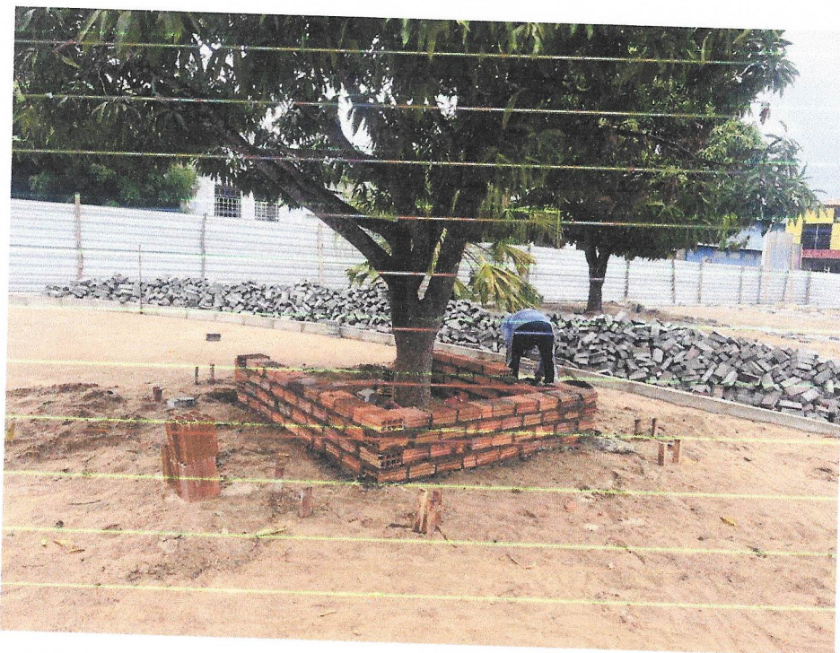
Foto 12 – Alvenaria de vedação de blocos cerâmicos furados na vertical de 9x19x39 cm (espessura 9 cm) e argamassa de assentamento com preparo em betoneira. af_12/202.
