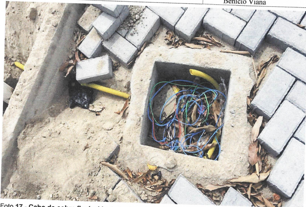
Foto 17 - Cabo de cobre flexível isolado, 6 mm 2 , anti-chama 450/750 v, para circuitos terminais - fornecimento e instalação. af_12/2015
